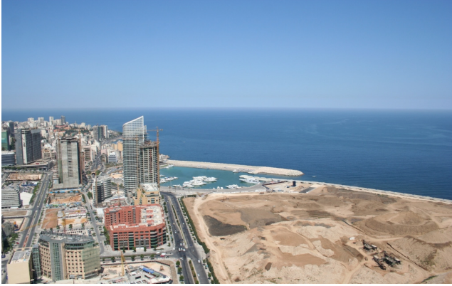
Figure 2. Vue du littoral avec le front de mer remblayé.
