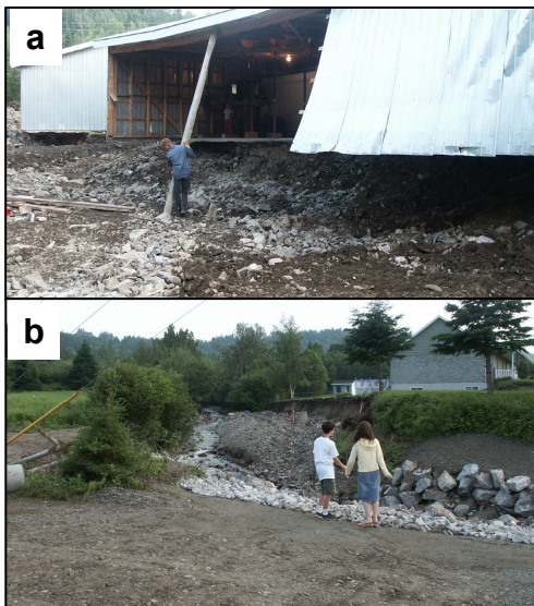
Figure 6. (a) La torrent a sapé les fondations d'un entrepôt appartenant à une entreprise de pêche, provoquant l'effondrement du mur arrière. (b) Le ruisseau Côté, près de la route 132. Le recul de la berge a détruit une partie de ce terrain privé, exhumant le système de traitement des eaux usées.
