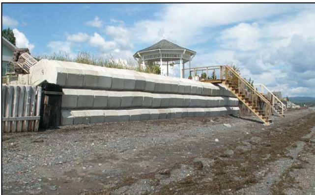
Figure 2. Mur de protection, secteur de la pointe Verte.
