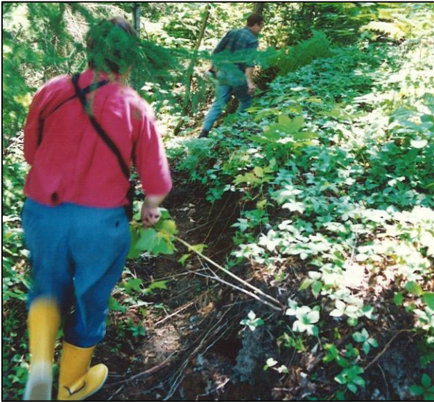
Figure 5 – Vue d'une des fissures majeures situées à proximité de la cicatrice du glissement. La personne se tient sur la partie qui a commencé à descendre.
